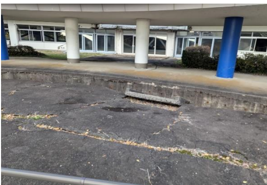
隆起し変形した、東海大学の玄関口 東海大学の学生も犠牲となった。
