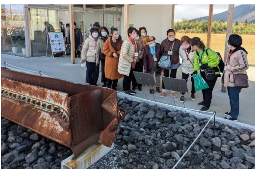
破壊された阿蘇大橋の橋げた部分
